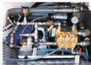
ホースカー昇降装置の奥に高圧ポンプを配置している。
