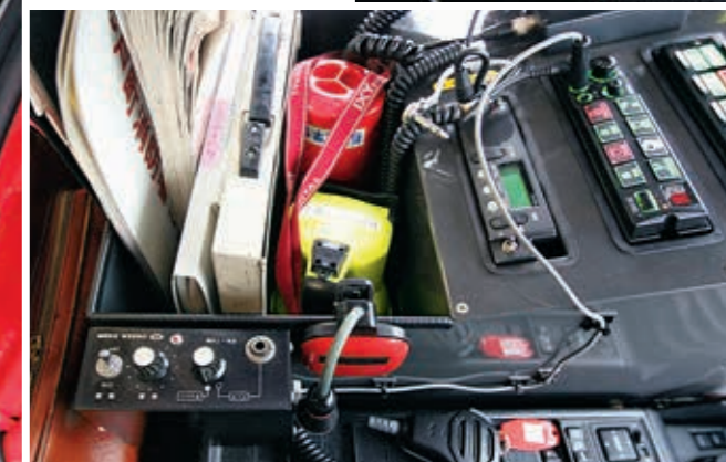
センターコンソールには2台のサイレンアンプが。杉戸町消防本部では救急支援出場時にピーパーサイレンを使用することとしており、別途サイレンアンプ(写真手前)を備えている。サイレン音はメインサイレンアンプのマイク端子より入力(使用時に配線を変更)する。
