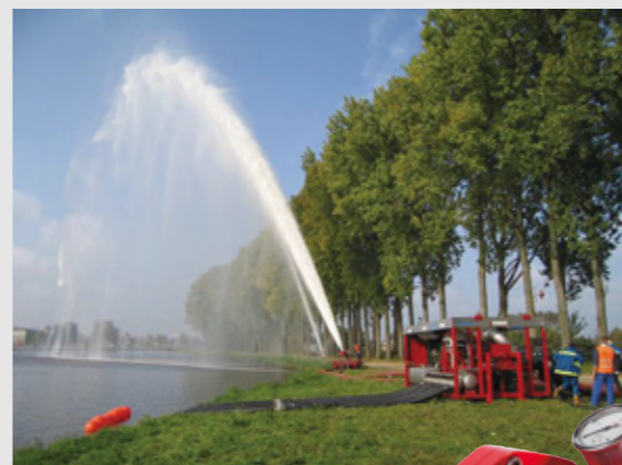
大型のFireDos混合システムと放水砲を組み合わせた、大容量泡放射システムとして運用することもできる。(写真提供/日本ドライケミカル)
