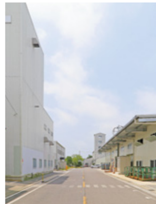
千葉県山武市にある日本ドライケミカルの千葉工場。ここで同社の様々な製品が開発されている。
