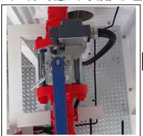
① 設置位置の確認 ボンベ庫内メイン管に設置されている閉止弁を確認します。
