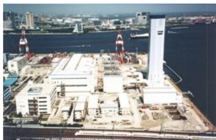
(東京電力 品川火力発電所)
