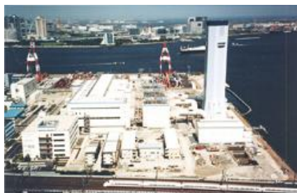
(東京電力 品川火力発電所)
