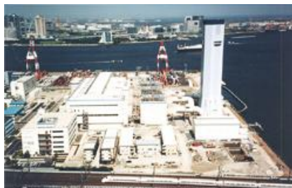
(東京電力 品川火力発電所)
