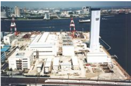
(東京電力 品川火力発電所)
