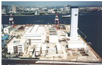
(東京電力 品川火力発電所)
