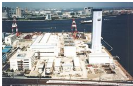
(東京電力 品川火力発電所)
