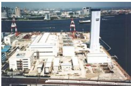
(東京電力 品川火力発電所)
