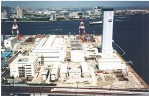
(東京電力 品川火力発電所)
