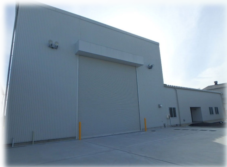
千葉工場 新研究棟 (可動式昇降天井)
