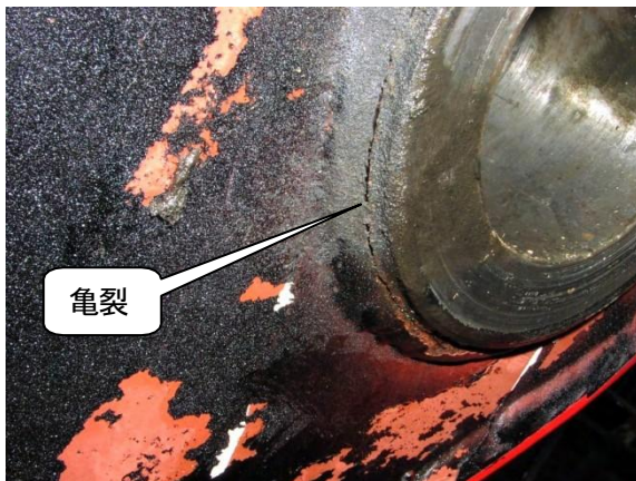
写真3 三角フレーム側
