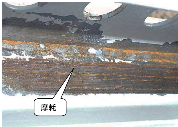
写真5 梯体パッドレール
