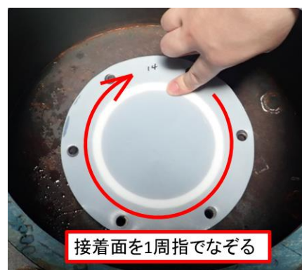
図 1 2. 封板取付け方法
