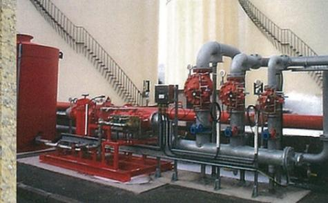
▲FireDos混合システムは固定式設備として世界各国の製油所などでも配備されている。(写真3点提供/日本ドライケミカル)
