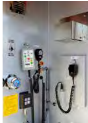
右側ポンプ操作室内には外部マイクと照明装置のコントローラー、無線用マイクを設置。
