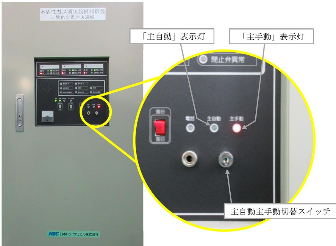
図3 主自動主手動切換スイッチの操作に係る箇所
