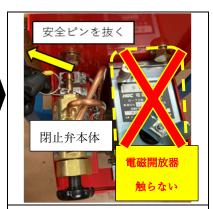
③ 安全ピンを抜く 写真のように安全ピンが差さっ ていることを確認した後、安全ピ ンを抜きます。
