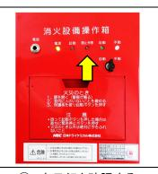
⑦ 表示灯を確認する 操作箱「閉止弁閉」表示灯が消 灯していることを確認します。
