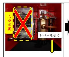
④ レバーを引く レバーを引き、弁を閉止します。 となりの電磁開放器は絶対に触 らないでください。起動し、消火剤 が出ます。
