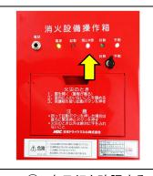
⑦ 表示灯を確認する 操作箱「閉止弁閉」表示灯が点 滅していることを確認します。
