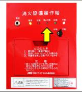
⑦ 表示灯を確認する 操作箱「閉止弁閉」表示灯が消 灯していることを確認します。
