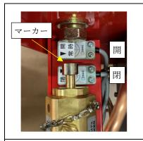
① 閉止状態の確認 マーカーが閉止位置になって いることを確認します。
