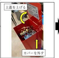
② カバーを外す上蓋を上げ、前面に取り付けられているカバーを持ち上げながら外します。
