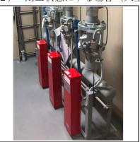
① 設置位置の確認 ボンベ庫内選択弁付近の起動 装置格納箱に付設されている 閉止弁を確認します。
