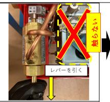
④ レバーを引く レバーを引き、弁を閉止しま す。
