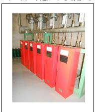
① 設置位置の確認 ボンベ庫内選択弁付近の起 動装置格納箱に付設されて いる閉止弁を確認します。
