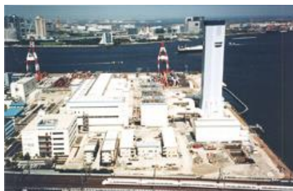
(東京電力 品川火力発電所)
