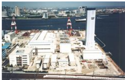
(東京電力 品川火力発電所)
