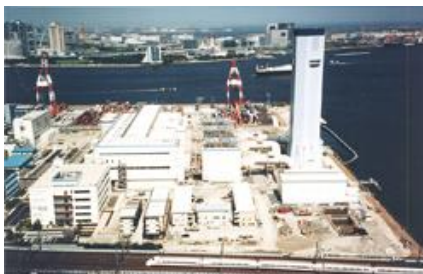
(東京電力 品川火力発電所)
