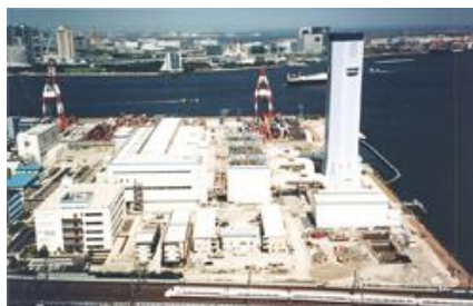
(東京電力 品川火力発電所)
