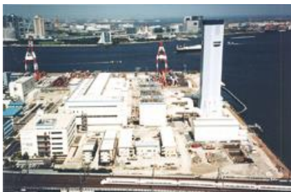
(東京電力 品川火力発電所)
