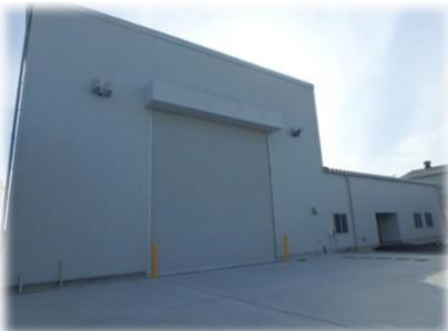
● 千葉工場 新研究棟
