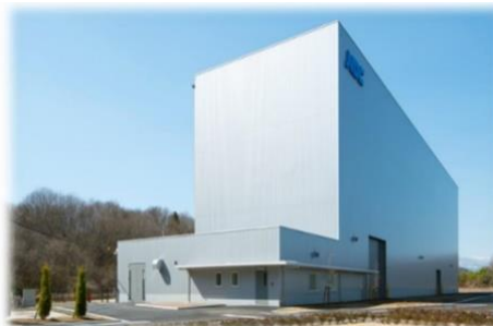
● 福島工場 総合防災研究棟
