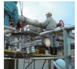
現場取付 (同社資料より)
