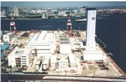
(東京電力 品川火力発電所)
