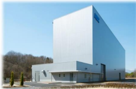
● 福島工場 総合防災研究棟
