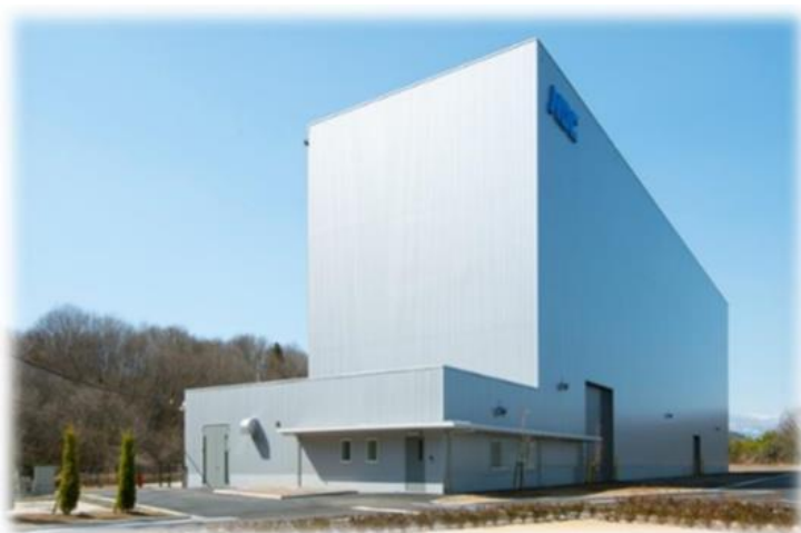
福島工場 総合防災研究棟
