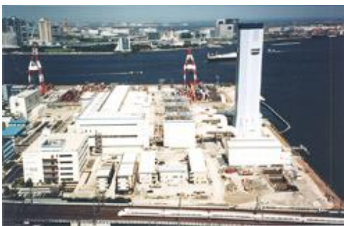
(東京電力 品川火力発電所)
