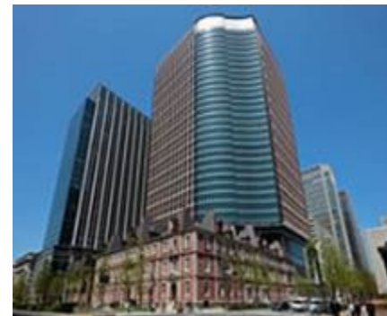
高層オフィスビル
