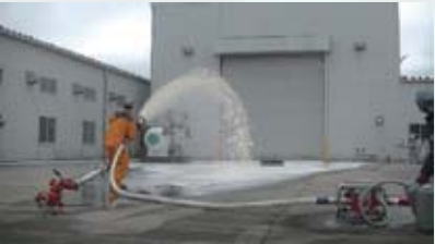
FireDos 混合システムによる泡放射
