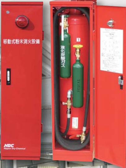
移動式粉末(第3種)消火設備
